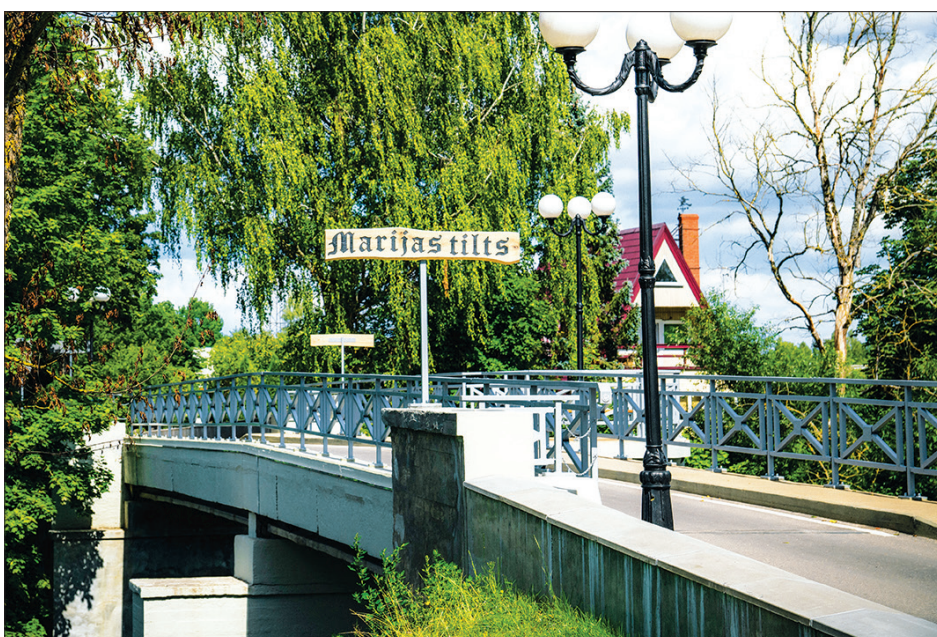
UZLABOTA DROŠĪBA. Pārbūves laikā veikts balstu remonts, izbūvēta skatu platforma, nostiprinātas nogāzes, pārbūvētas un no jauna izbūvētas betona atbalstsienas un margas, izveidota ūdens novadsistēma un veikti citi darbi.
