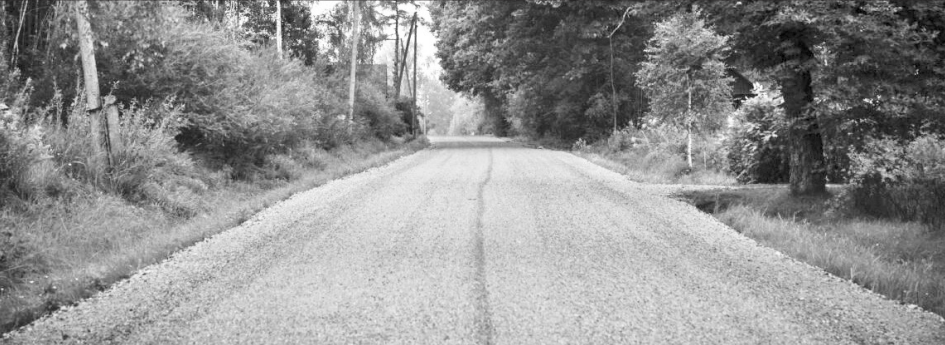
JAUNJELGAVĀ, JAUNAJĀ IELĀ, pēc grants ceļa virsmas divkārtu apstrādes ielai būs melnais segums. Foto: Vitālijs Prutskis
