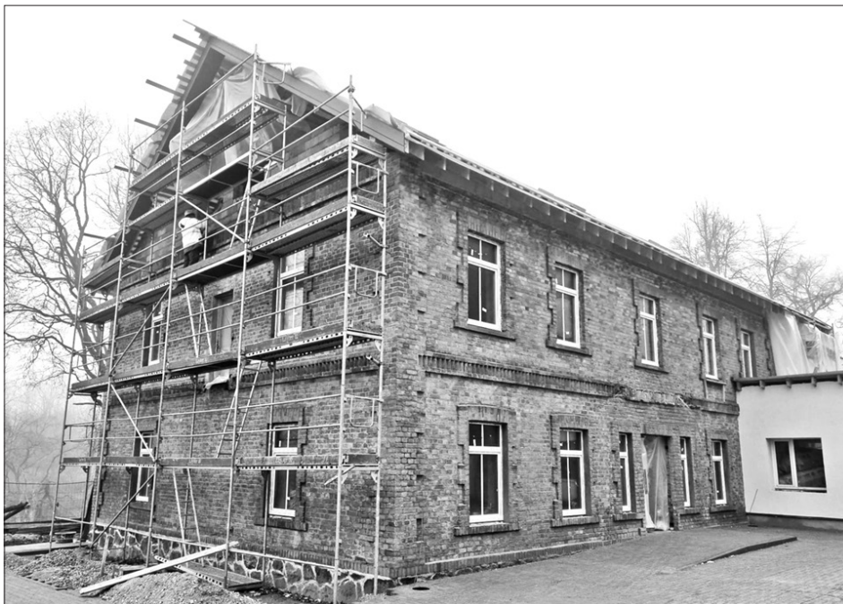
ĒKA, kurā būs Skrīveru daudzfunkcionālais sociālo pakalpojumu centrs, tiek pilnībā pārbūvēta, saglabājot vien sākotnējo sarkano ķieģeļu fasādi. (centrs)
