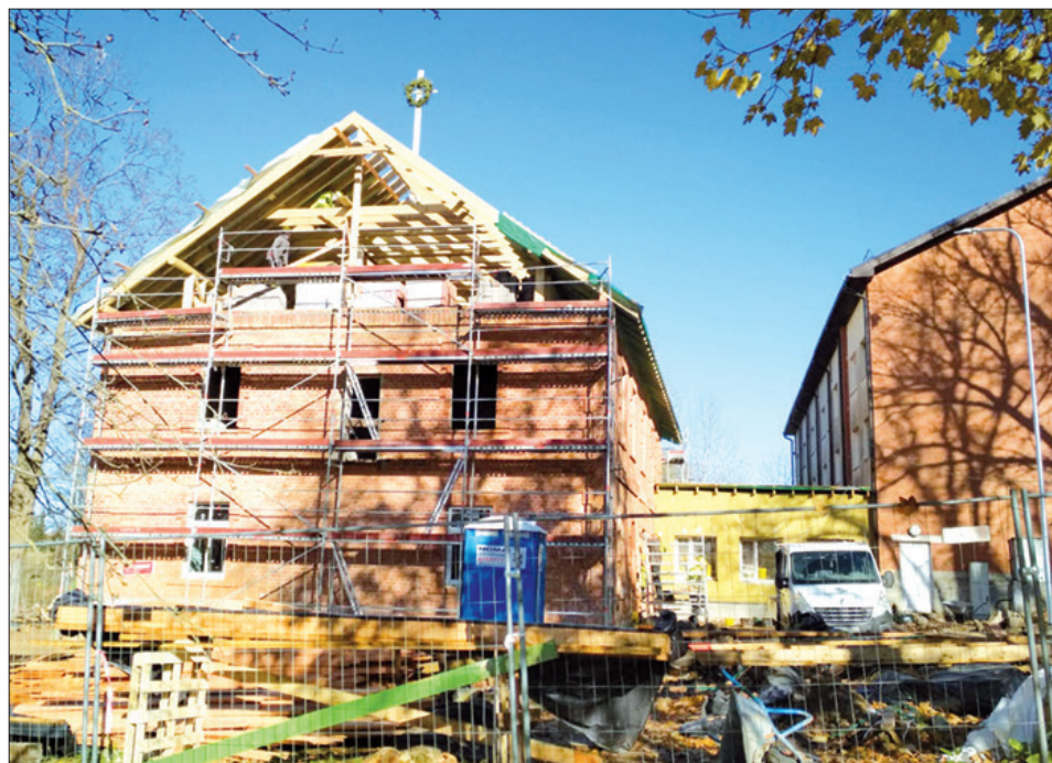
SPĀRU SVĒTKI ēkā Daugavas ielā 85A, kur top Skrīveru daudzfunkcionālais sociālo pakalpojumu centrs.
